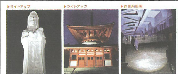
高さ57mの観音様 (前) 水銀灯12kW → (後) COB 270W (設置) COB 60W (設置) COB 135W
